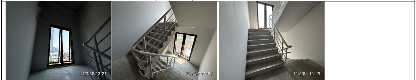
รูปที่ ผ7.45 ช่องระบายอากาศบริเวณชานพักบันไดหนีไฟ
